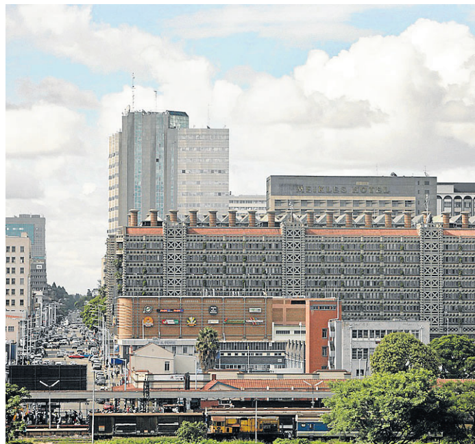
El edificio Eastgate en Harare, Zimbabwe, fue construido imitando los termiteros sin necesidad de aire acondicionado. MICHAEL PEARCE, CREATIVE COMMONS-WIKIMEDIA
